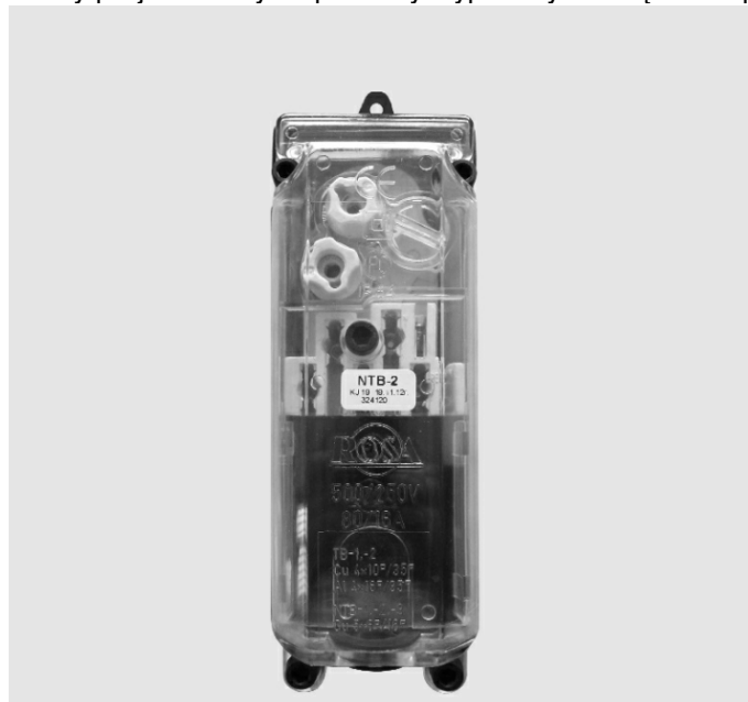
Rysunek 1-widok tabliczki bezpiecznikowej w słupie
